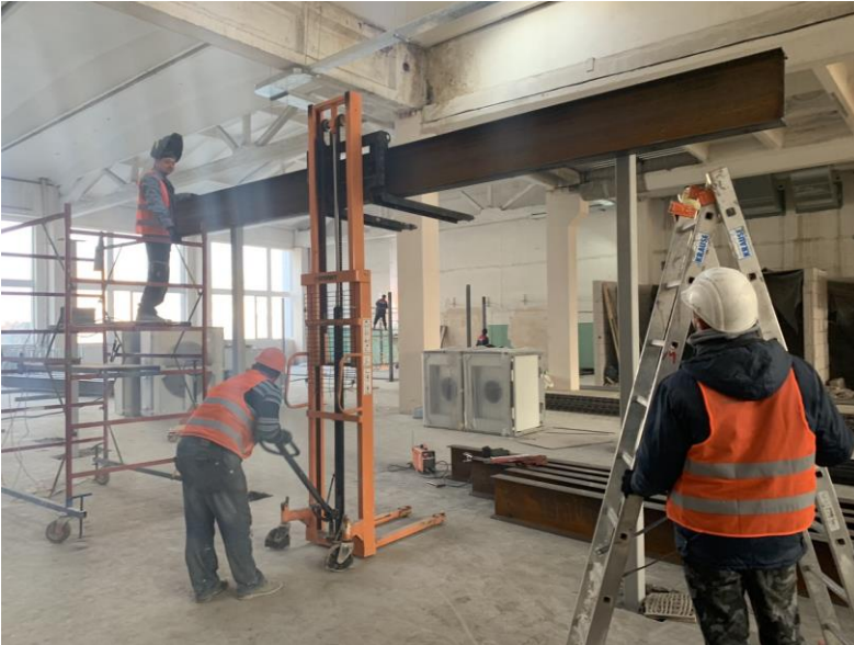
Рис.2. Монтаж несущих металлоконструкций балок перекрытия антресоли при помощи ручного гидравлического штабелера
