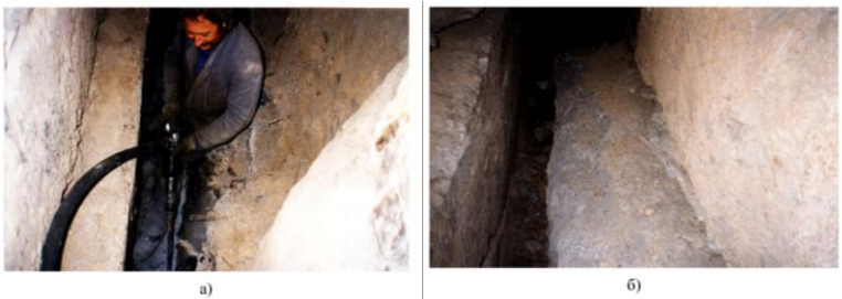
Рис. 3. Влаштування деформаційного шва: а) пошарова вирубка бетону між шпурами; б) готовий деформаційний шов
