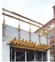
Рис. 5. Захисні бар'єри, закріплені на залізобетонних елементах
