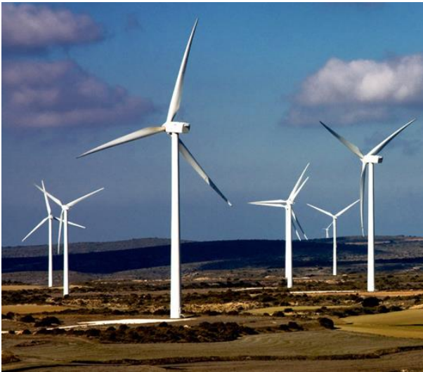
Рис. 1 – Найпотужніша вітрова електростанція України, Ботієвська ВЕС
