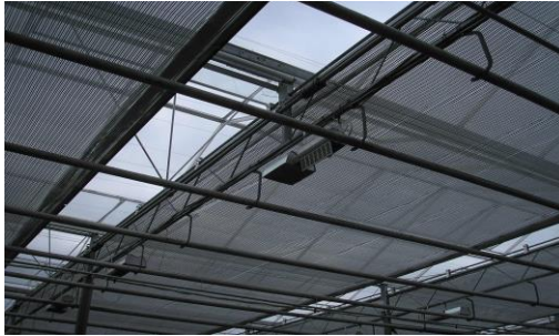
Рис.1. Горизонтальна трособлокова система зашторювання
