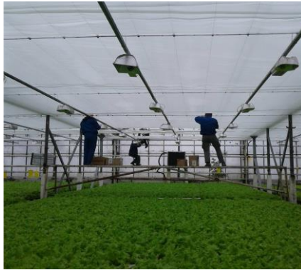
Рис.4. Монтаж системи горизонтального зашторювання
