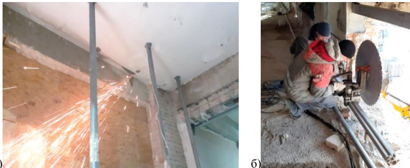
Рис. 3. Влаштування розділової щілини між перемичкою та плитою перекриття: а- тимчасові кріплення плити перекриття; б- влаштування розділової щілини
