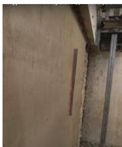
б – розподіл розчину та укладка й розглажування суміші по вертикальній поверхні
