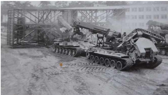
Рис. 3. Фото-фрагмент виконання робіт на будівельному майданчику
