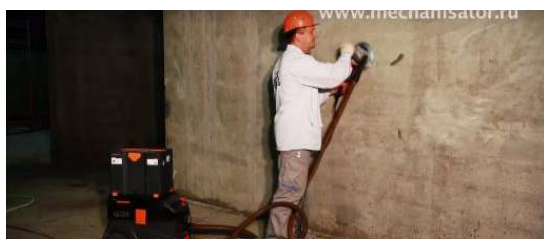
а – очищення поверхні
