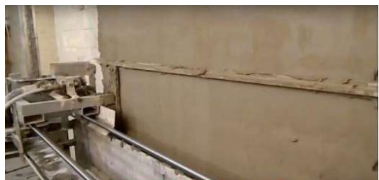
б – розподіл розчину та укладка й розглажування суміші по вертикальній поверхні
