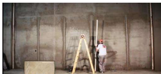
е – встановлення маяків
