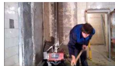
б – подача розчину в бункер
