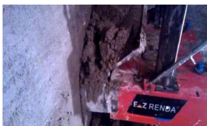
в – нанесення розчину на поверхню
