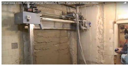
б – розподіл розчину та укладка й розглажування суміші по вертикальній поверхні
