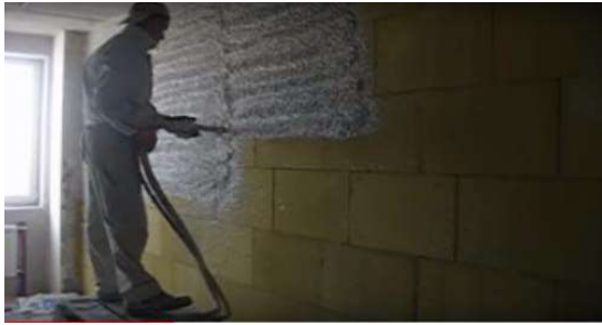
ж – нанесення розчину на поверхню – 20 – 30 см.
