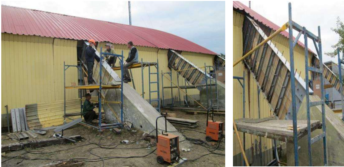
Рис. 4. Процес збирання та установки металевих обойм
