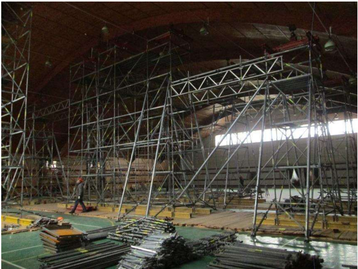
Рис. 2. Процес установки риштувань ТОВ «ПЕРІ Україна»
