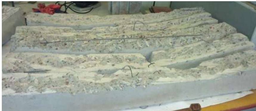
Рис. 1. Балки підготовлені до відновлення: а – схема підготовленої балки; б – фото підготовленої балки
