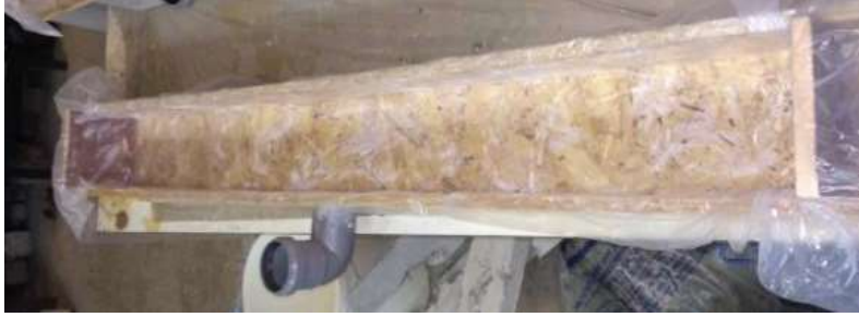
Рис. 3. Загальний вигляд опалубної конструкції
