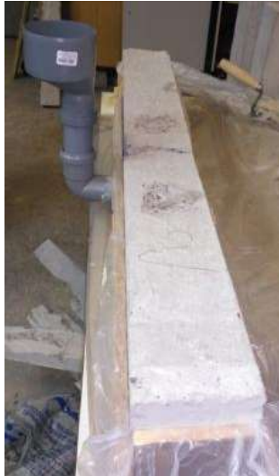
Рис. 4. Балка встановлена в опалубну конструкцію та готова до відновлення
