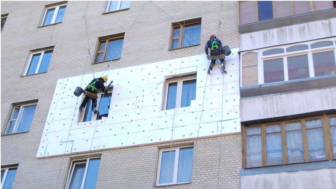
Рис. 2. Утеплення зовнішніх стін частини будівлі ланкою альпіністів
