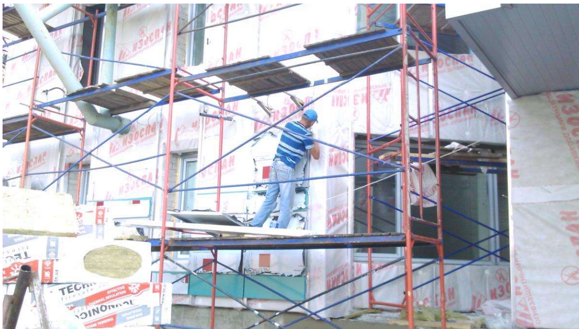
Рис. 1. Влаштування теплоізоляції будівлі способом «вентильований фасад»
