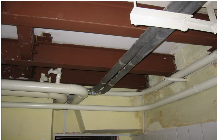
Рис. 3. Вигляд елементів підсилення перекриття способом «опори-балка»
