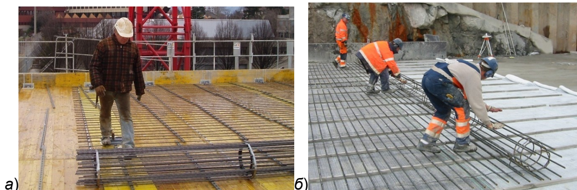
Рис. 1. Раскатывание первого рулона нижнего армирования: а – на перекрытии; б – на бетонной подготовке фундаментной плиты
