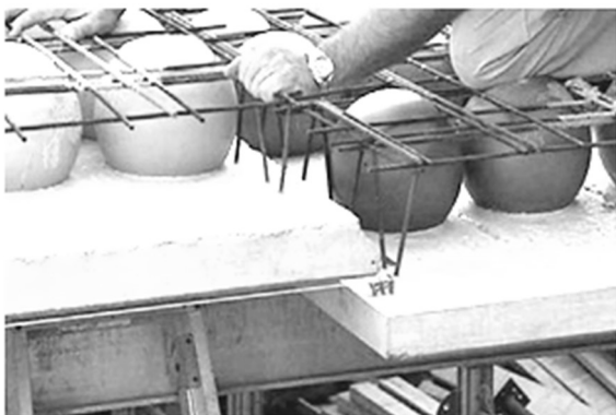
Рис. 4. Процес монтажу армопалубної панелі плити перекриття на риштування.
