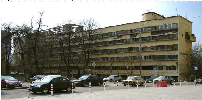
Рис. 4.а. Загальний вигляд будівлі Наркомфіна до її реконструкції
