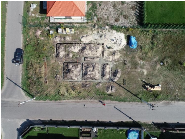
Рис. 2. Фотофіксація влаштування підземної частини фундаменту котеджного будинку в КМ «Міжріччя» 4 вересня 2021р.
