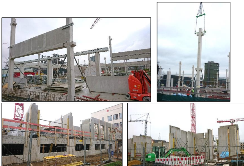
Рис. 3. Монтаж збірних конструкцій колон, балок та стінових панелей
