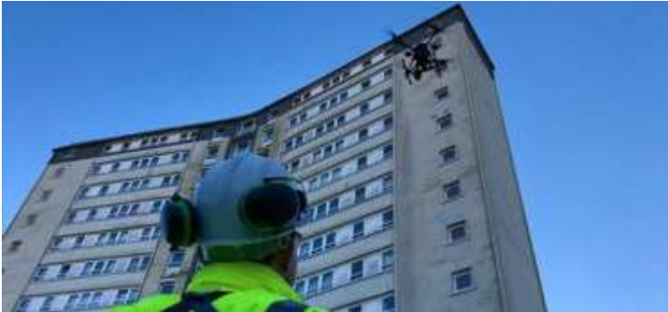
Рис. 1. Використання дрону для обстеження фасаду будівлі
