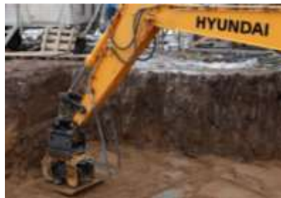
Рис. 4. Ущільнення ґрунту навісними гідротрамбівками
