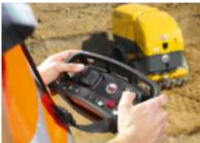
Рис. 3. Ущільнення ґрунту мінікотками
