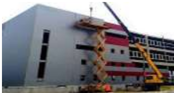
Рис. 4. Монтаж збірних панелей каркасу будівлі та герметизація стиків панелей
