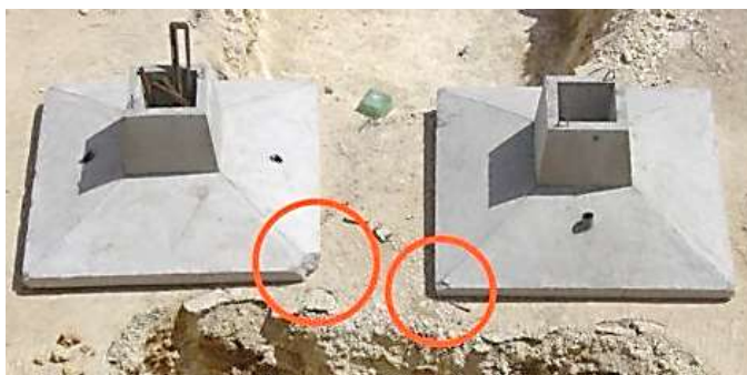
Рис. 5. Вигляд пошкоджень фундаментів, доставлених на будмайданчик [5]
