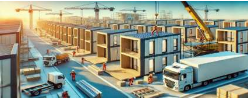
Рис. 6. Швидке будівництво модульний будинок
