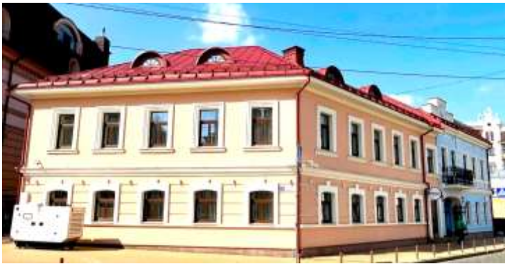
Рис. 6. Вигляд відреставрованої будівлі в м. Києві по вул. Покровська, 9 (садиба міська, ХІХ ст., номер в реєстрі 3200-Кв [3]) (фотографія автора, березень 2025 року)
