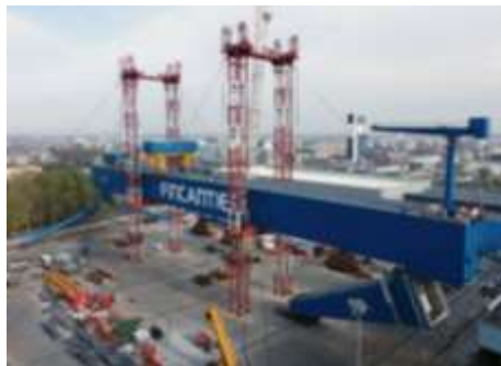
Рис. 5. Щогловий гідравлічний тросовий гідропідйомник FAGOLI
