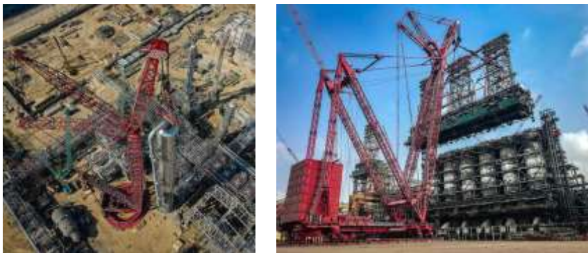
Рис. 1. Приклад використання гусеничного крану Mammoet SK6000
