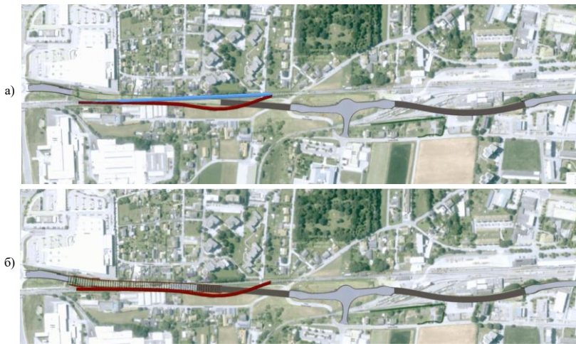
Рис. 4. Етапи адаптивного будівництва підземно-наземного об'єкта критичної інфраструктури: а) початок реалізації будівництва; б) завершення монолітних робіт на декількох ділянках [8]
