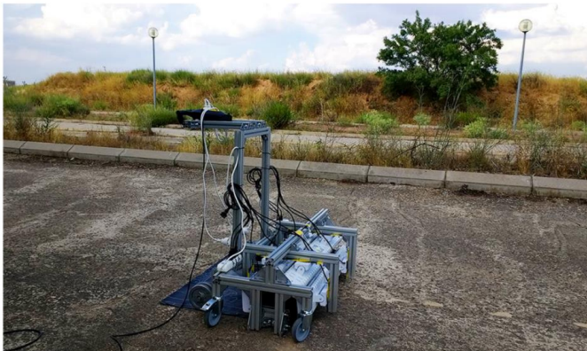
Рис. 4. Підключений та готовий до тестування прототип установки для укладання рулонної покрівлі
