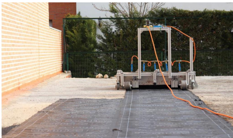
Рис. 7. Влаштування рулонної покрівлі за допомогою установки з п'ятьма пальниками
