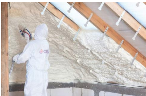
Рис. 5. Фото-фрагмент процесу утеплення горища
