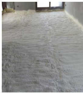
Рис. 6. Фото-фрагмент утеплення підлоги
