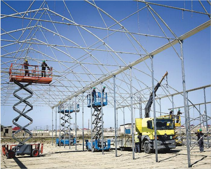
Рис. 3. Монтаж каркасу плівкових теплиць з використанням мобільних самохідних підйомників та вантажного автомобіля з краном – маніпулятором
