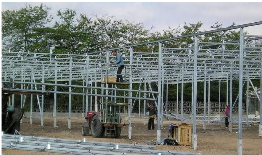
Рис. 1. Монтаж каркасу скляних теплиць четвертого покоління з використанням самоходної установки на базі трактора з гідравлічною платформою та виличного навантажувача
