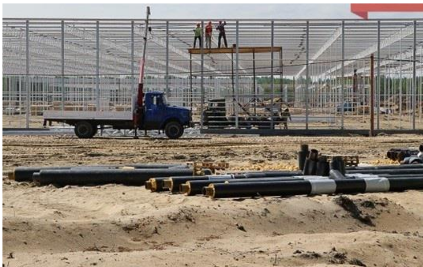
Рис. 2. Монтаж каркасу скляних теплиць четвертого покоління з використанням самоходної установки на базі автомобіля з жорсткою платформою та кран-маніпулятора
