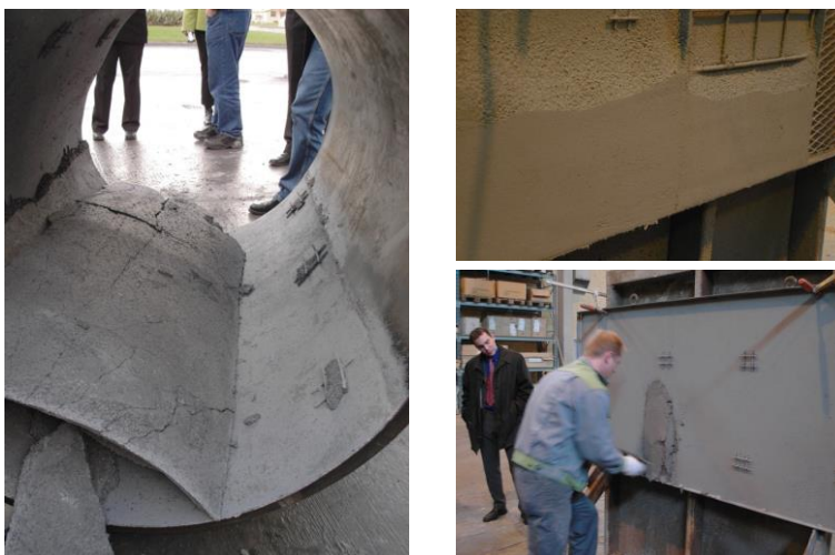
Рис. 3. Відшарування та деформація захисного покриття фрагментів труб футерованих фібро-бетоном
