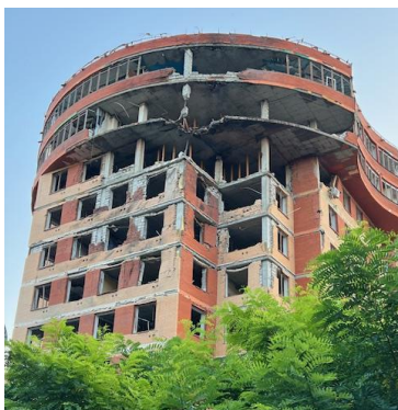
Рис. 12. Вид та ступінь пошкодження збірної системи з облицюванням цеглою при влучанні вибухового елементу безпосередньо у будівлю
